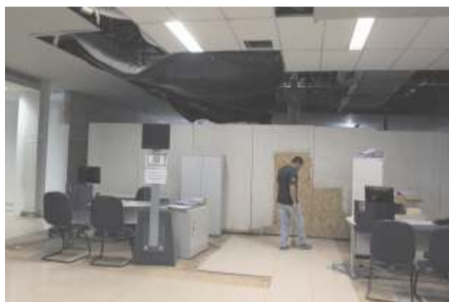
Situação da agência colocava em risco a saúde dos funcionários
